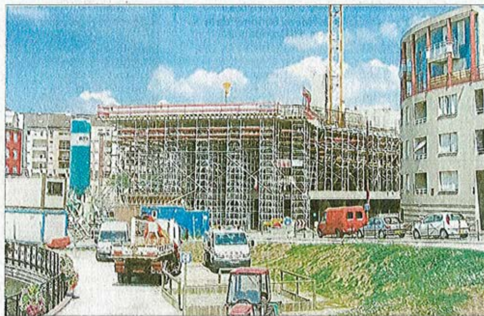
Chantier de la construction de l'espace culturel de La Turbine. Photo Archives mairie de Cran-Gevrier
